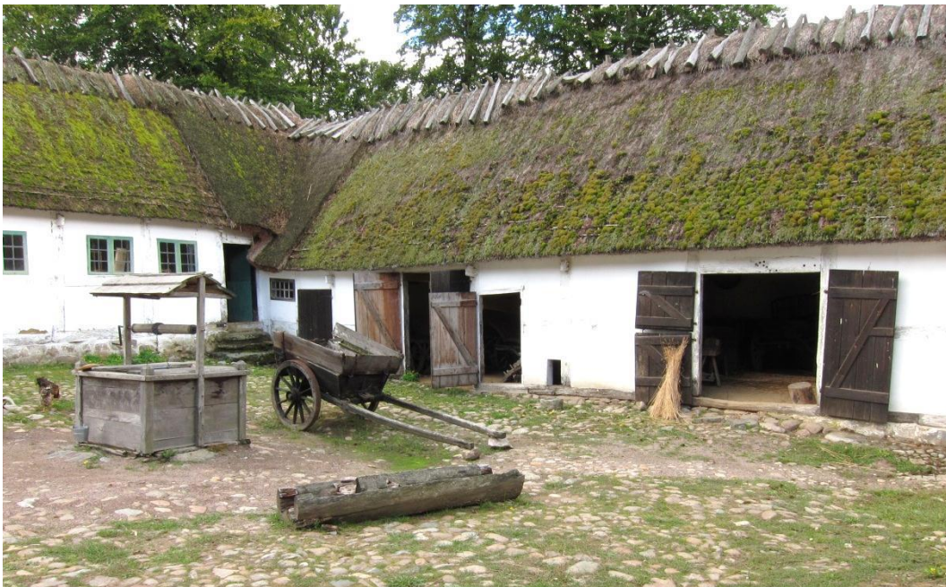
Figur 9. Gamlegård är uppförd på 1810-talet och är den enda av gårdarna som ligger kvar på den tidigare bytomten.
